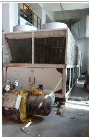
八里垃圾焚化廠氣冷式冰水主機 4 臺(財編:301030505-000006、7、8、9)
