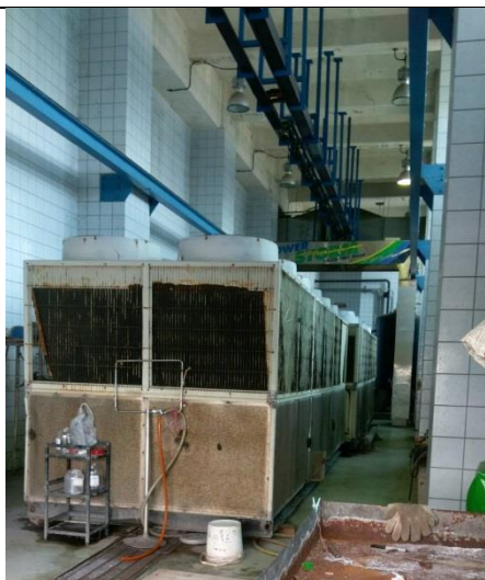
八里垃圾焚化廠氣冷式冰水主機 4 臺(財編:301030505-000006、7、8、9)
