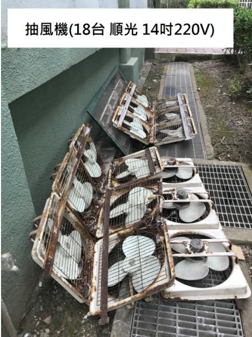
八里垃圾焚化廠抽風機 18 臺
