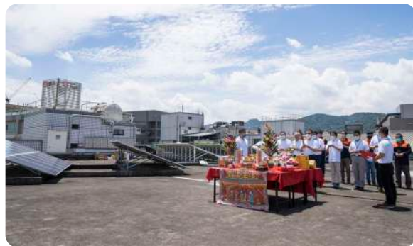
▲ 鴻海虎躍廠樓頂新建太陽能系統開工祭祀
