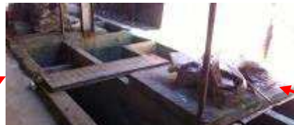
廢水處理設施為下挖式槽體
