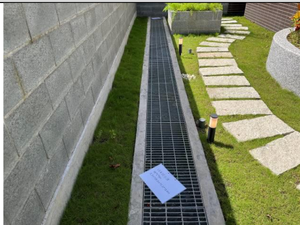
完工水保設施-排水溝
