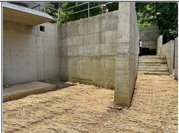
完工水保設施-擋土牆
