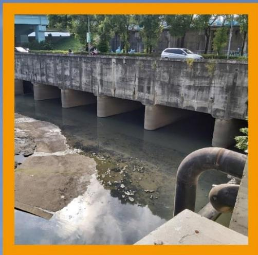
遇市區內因雨水無法以重力方式排出時，利用抽水站抽水機以機械動力方式抽放至河流，以避免都市區內發生積水或淹水，當河川水位較低時，則開啟閘門，將市區雨水以重力方式排放至河川。若河川水位持續上漲至抽水站之警戒水位時，則須立即關閉閘門，以避免河水倒灌入市區。
