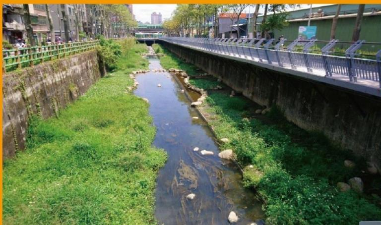
水利局在防洪無虞前提下，透過鋪設抗沖蝕網及鋪排砌石，栽種水生植物營造生物棲息空間，推動全面綠化工程，營造為都市型近自然河川，提供適合動植物成長的環境，也提升當地居民的生活品質。
