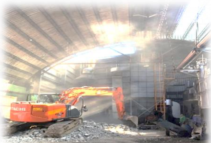
拆除燃煤鍋爐，新北提前達成無煤城市目標
