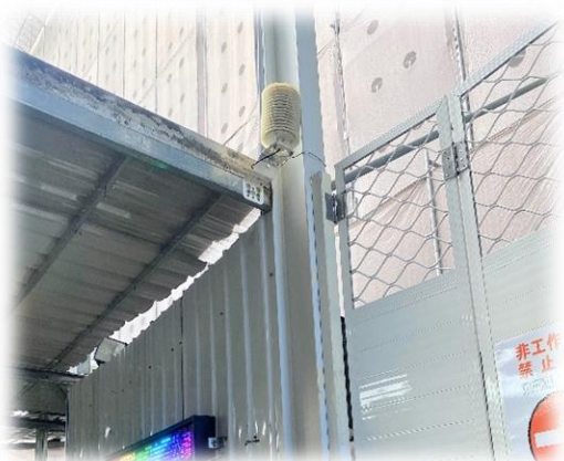
工地出入口設置噪音計及空品感測器
