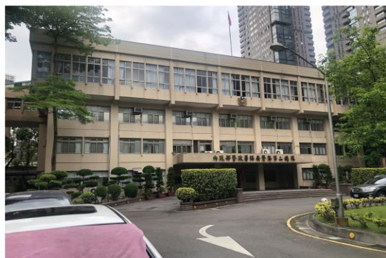
中和區景新段63地號等6筆土地(更新前照片)
