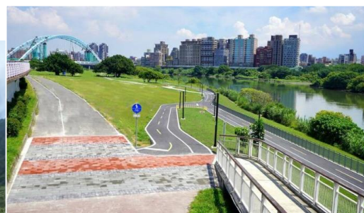
成蘆橋下(洲尾橋至成子寮橋間)車道拓寬至4公尺
