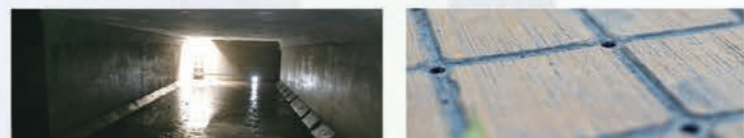
▲五股區成州國小地下蓄水池，能貯存500噸的雨水，提升基地保水能力，改善校區易積水問題。 ▲三重區三德公園的透水鋪面近拍照，水能藉由地面上這些孔隙向下滲入地下蓄水池中。
