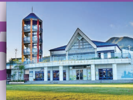
建物節能監控、建物節能 改造、建物零碳電力
