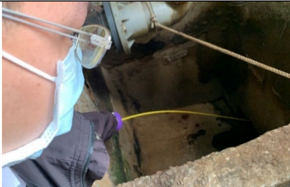
使用管線探測(內視鏡)
